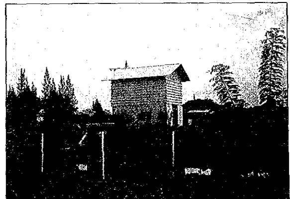
チャオピアパイロットプロジェクト主ポンプ場
