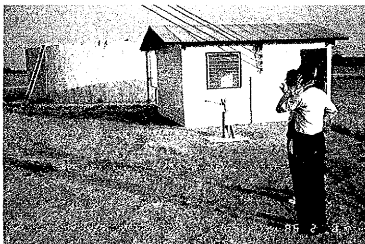
モデルインフラ整備により建設された貯水タンク
