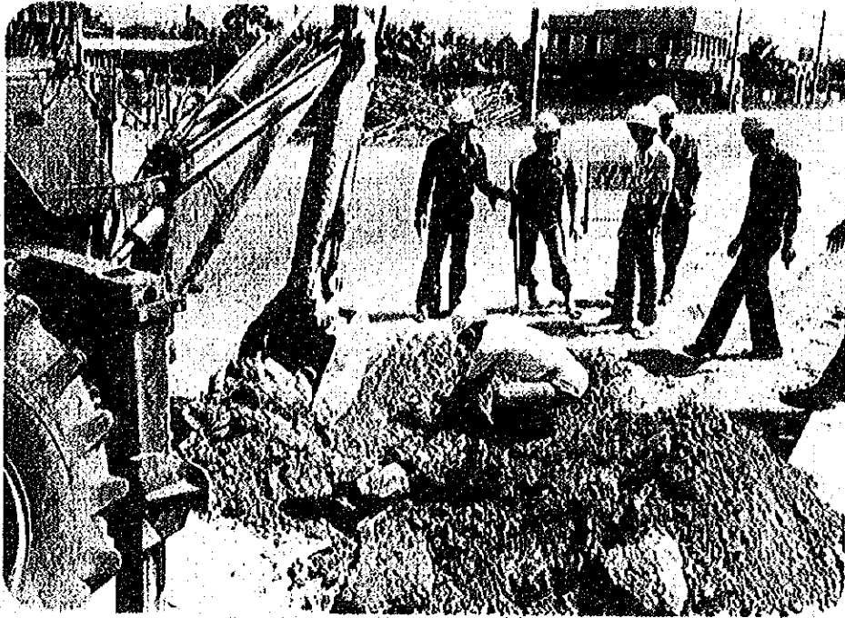
7. スクムビット通り沿いのマンホール調査 (道路拡張工事のため埋没したマンホールをパワーシャベルにより探索)
