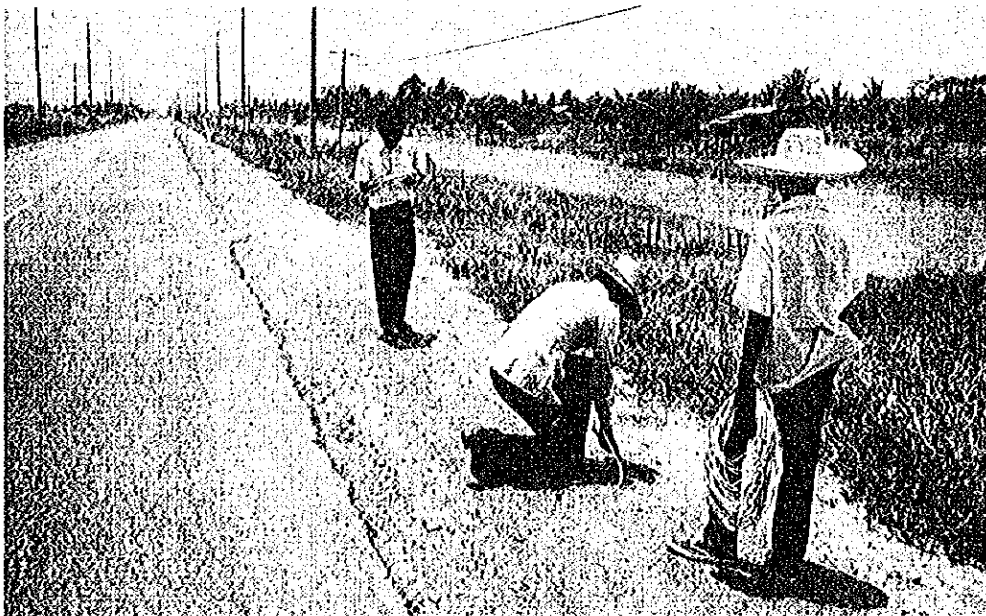
2. サミットプラカン局とバンブー局間の架空ケーブルルート測量
