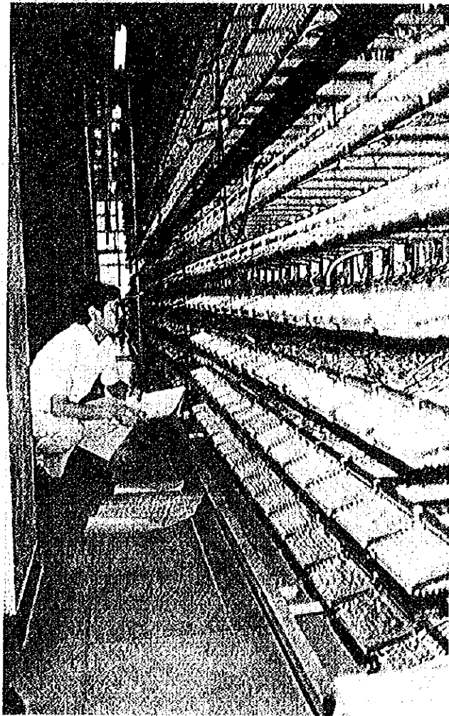
5. サムランラット局の木配線盤の調査
