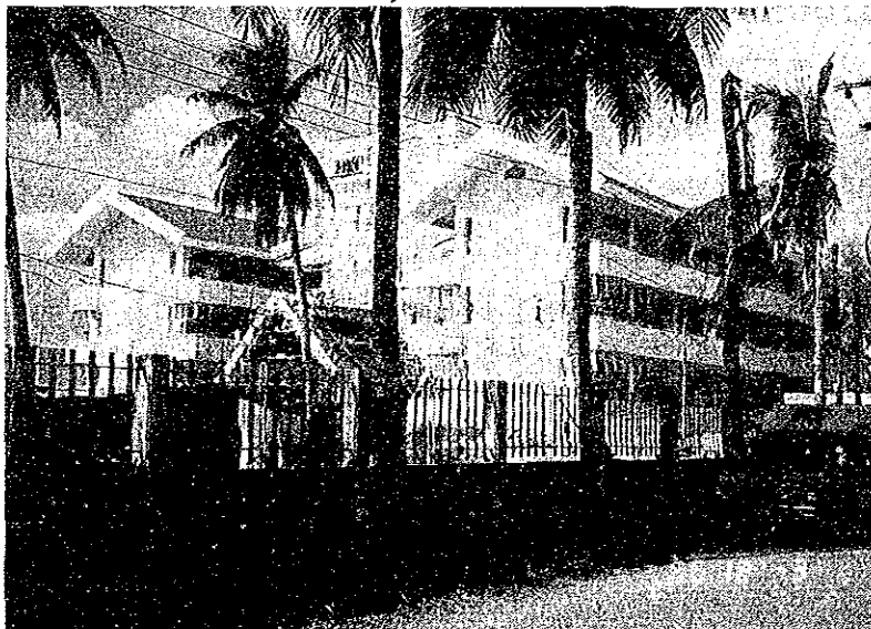
建築中のMIDI本館 (第2期計画により写真左側に実験工場を予定している)
