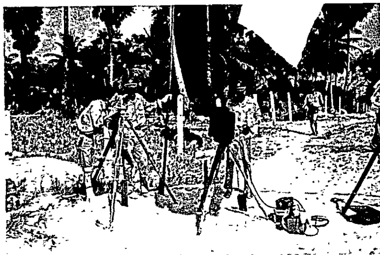
タイ国陸揚予定地の測量作業
