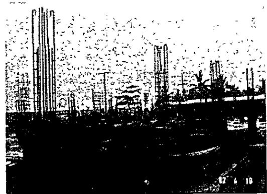
厨房棟 (平家建て鉄筋本数多い, 手前は定尺異型鉄筋 $l=10m$ )
