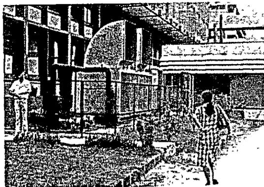
井戸水で冷却している外気処理空調機
