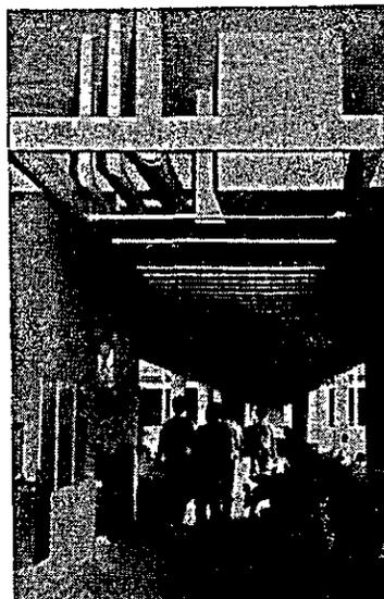
渡り廊下の電気配管（幹線）（総合研）
