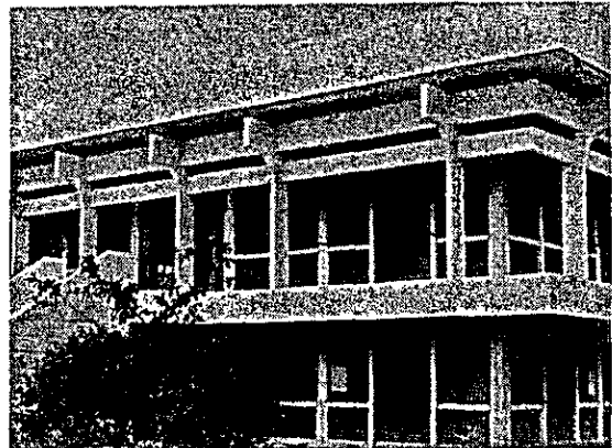
写真14. ラブリ職業訓練センター管理棟
