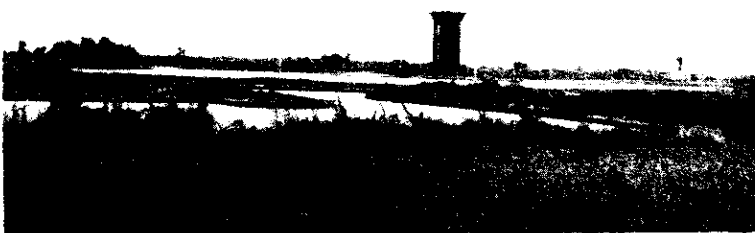
中央広場より建設中の高架水槽をみる
