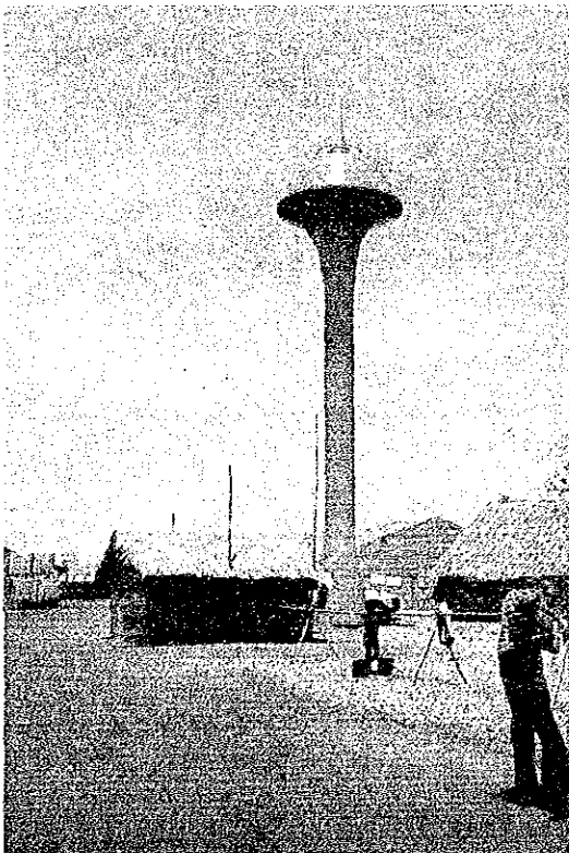
ポンプ小屋と給水塔完成
