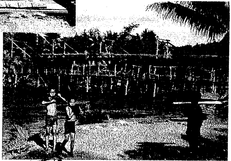
写真Ⅲ-12 木橋施工風景(南カリマンタン州バンジャール)
