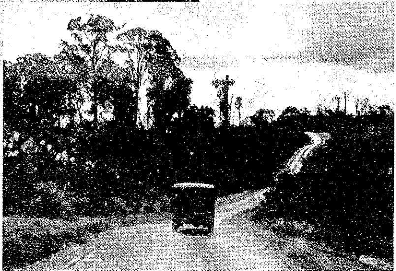
カンパニー道路 → (木材搬出用道路)
