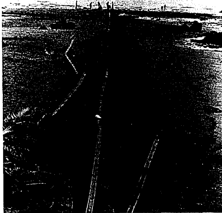
Photo 6 Takisong 海岸における水圧式検潮儀 の設置作業
