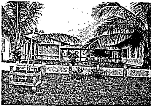
旧病棟の渡り廊下 換気扇の見えるのはX線室
