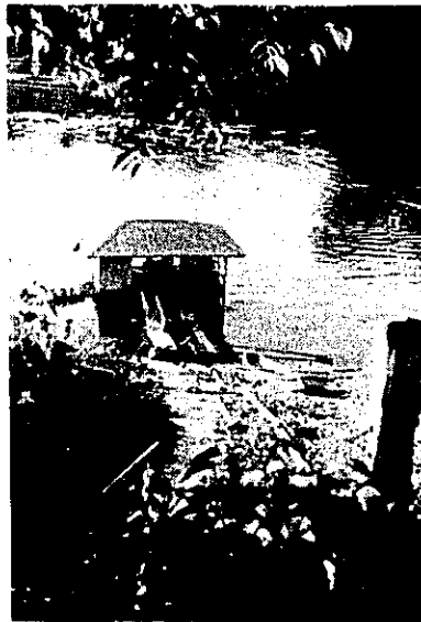
(3) ポンプ場 (ナムグム河より揚水している)
