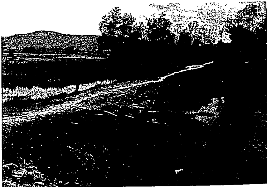
Photo 20. Prey Nop の塩水防禦堤防, 低く簡単なもので年々補修を要するというが, これにて塩水を防ぎ効果をあげている。
