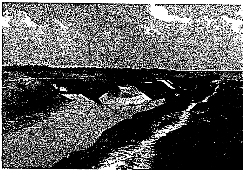
Photo 52 主幹線水路は約4 km地点、第2幹線水路を分岐し、この7.875 km地点で第5、第6幹線水路に分かれる
