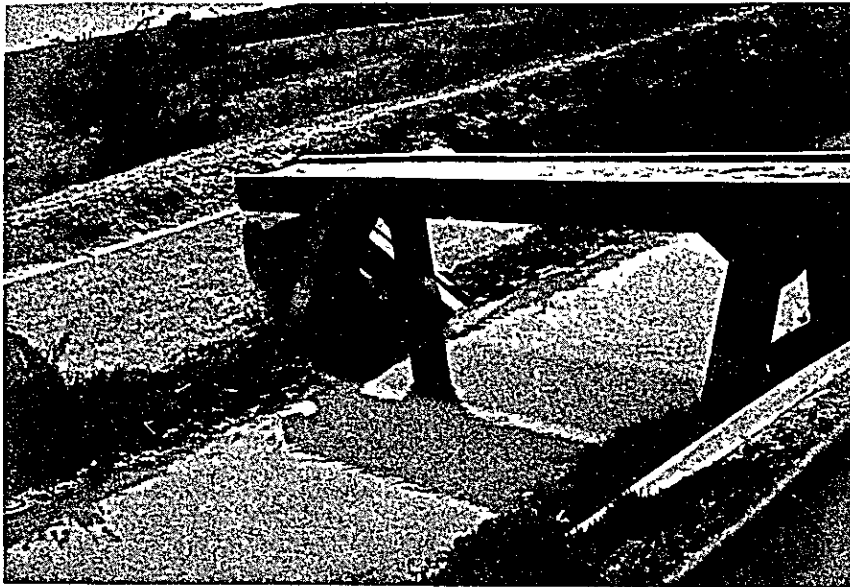
Photo 54 堰上げ用施設，支線に分水するための水位調節用構造物で，骨組だけが，コンクリートでつくられ必要に応じ木材粗朶で堰上げを行なう
