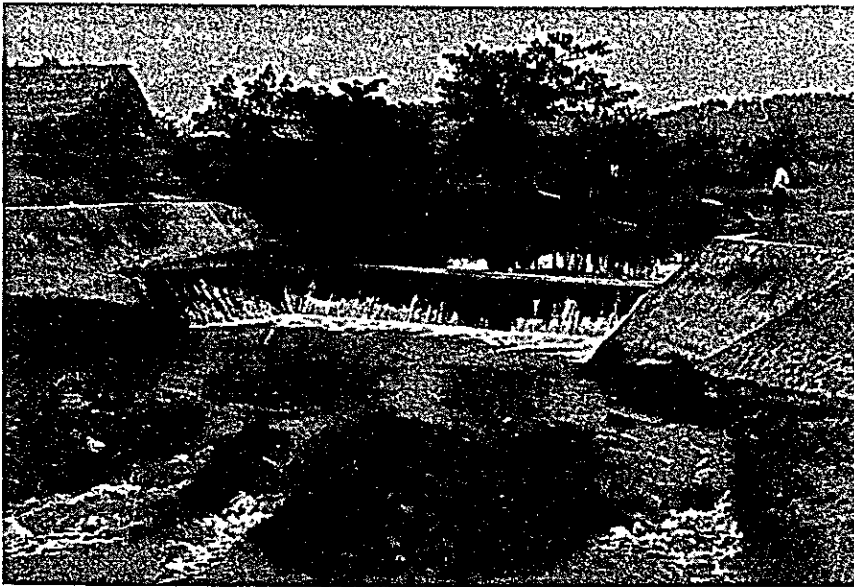
Photo 34. St. Bamnak の取水堰
