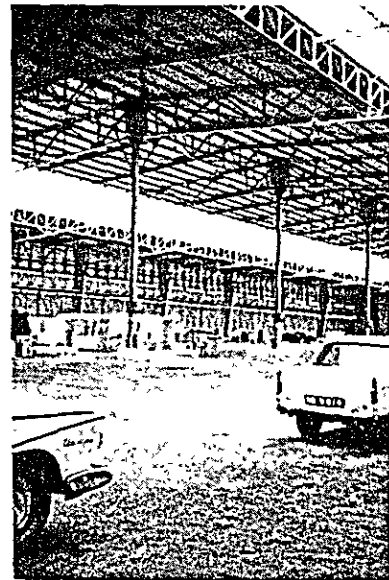
12. シアヌークビル港の上屋の内部
