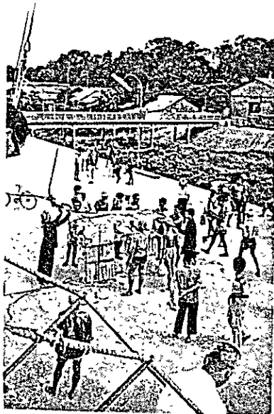
6. 同横棧橋における荷役状況
