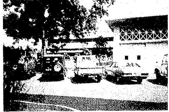
④ 事務棟から研究所を望む（手前給水塔）
