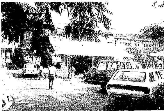
③ 事務棟（後方建物）
