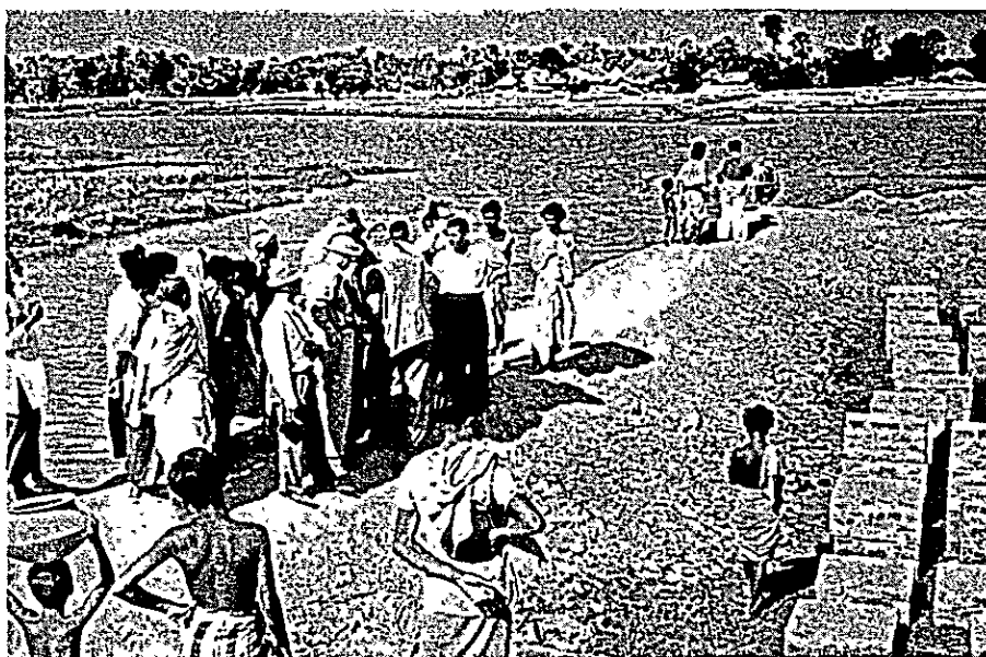
写真-42 排水門工事現場と調査団 (バキスタン, 写真-17 同所)
