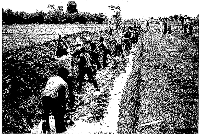
施工中の排水路
