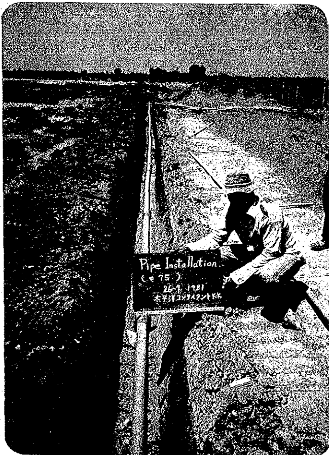
施行中の幹線水路
