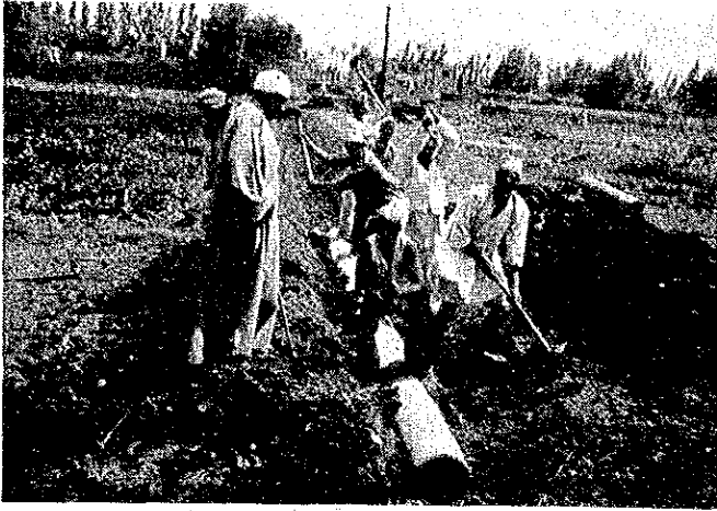
施工中の用水路
