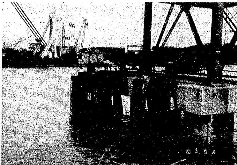
写真-C.1 ドルフィン脇に設置されている試験杭
