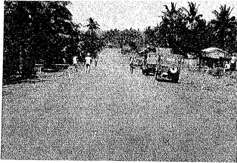
写真 4.5 Ti aman 付近 (Asphalt, Good) 国道
