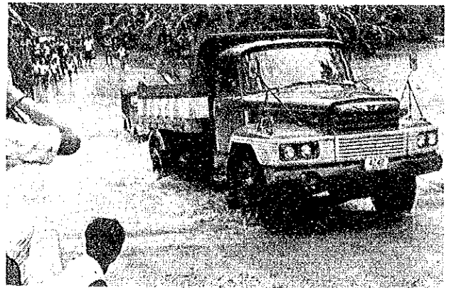
台風で冠水したミンドロ島の Calapan と Puerto Galera 間の幹線道路
