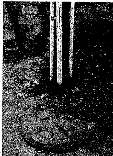
写真-⑦ 局前マンホール
