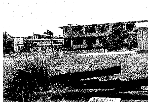
新館建設予定地
