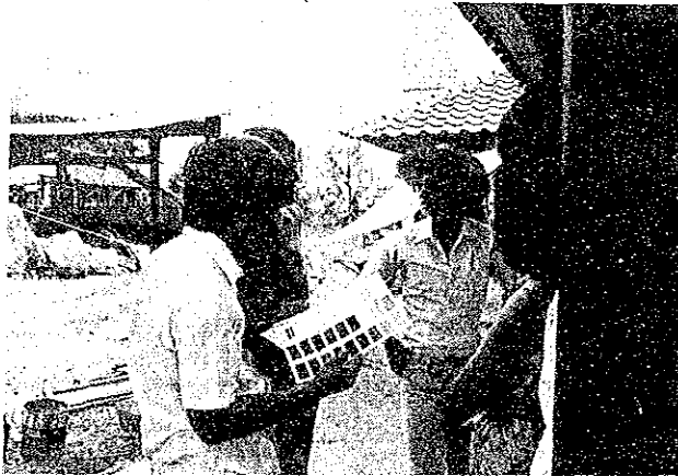
( 現場で工程管理の打合せを PWDの現場監督及び業者と行う )
