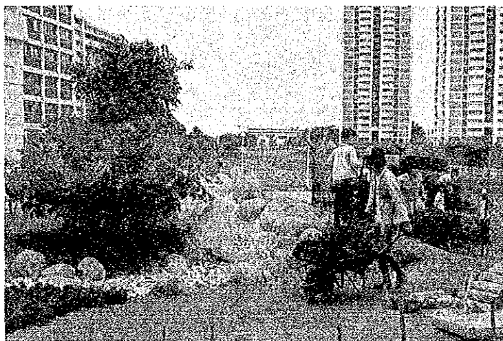
□浜の石組完了 植物の搬入
