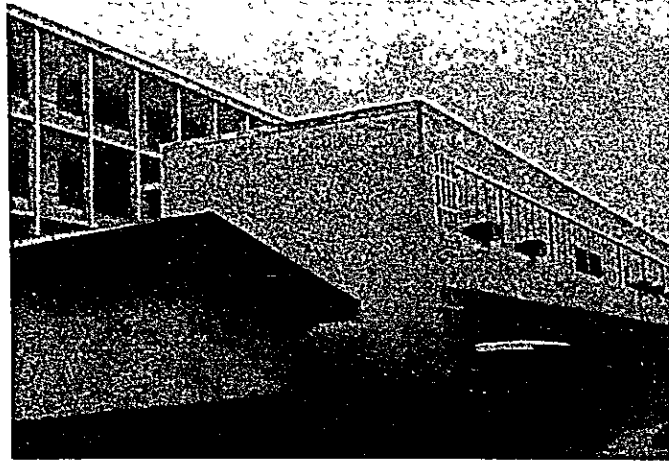
5) San Lazaro 病院 本館
