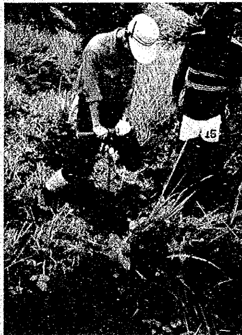
簡易地盤耐力テスト (コーンペネトレーションテスト)
