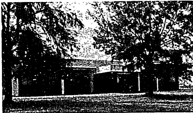
淡水養殖センターの既存建物 ( 研究棟 )
