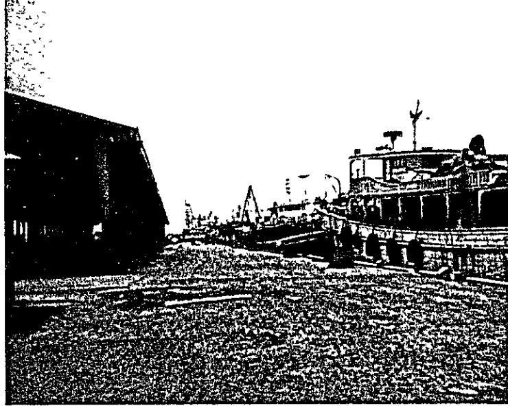
ナボタス漁港水揚岸壁
