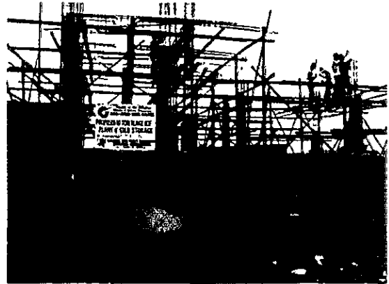
建設中のBFAの製氷・冷蔵施設 (San Jose)
