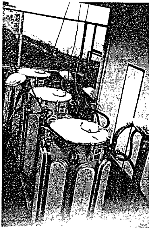
電 気 室 の ト ラ ン ス
