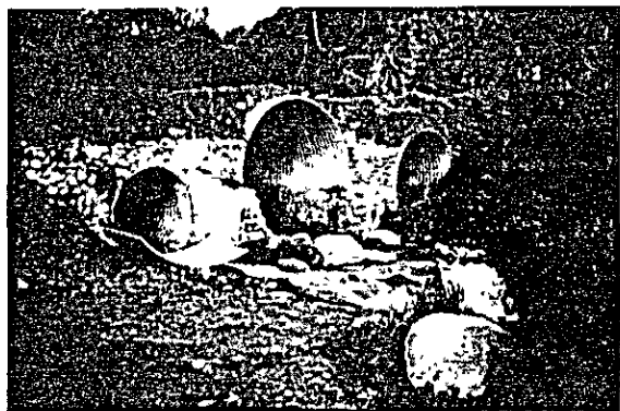
コルゲートアーチ及びコルゲートパイプの 組合せ使用
