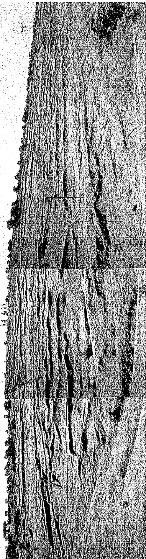
▲ 下流側より見たダム下流法面すべり状況
