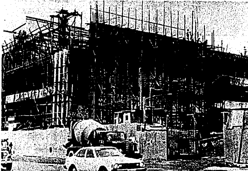
工事現場の木製外壁足場と鋼板製仮囲い
