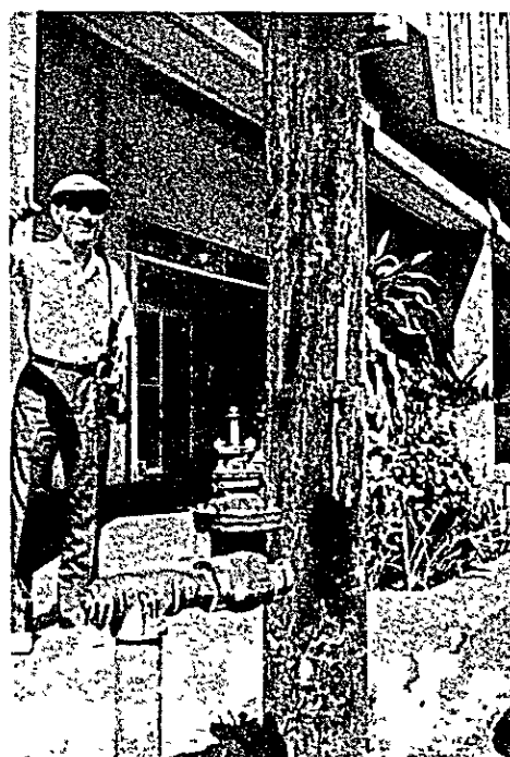
地上式消火栓
