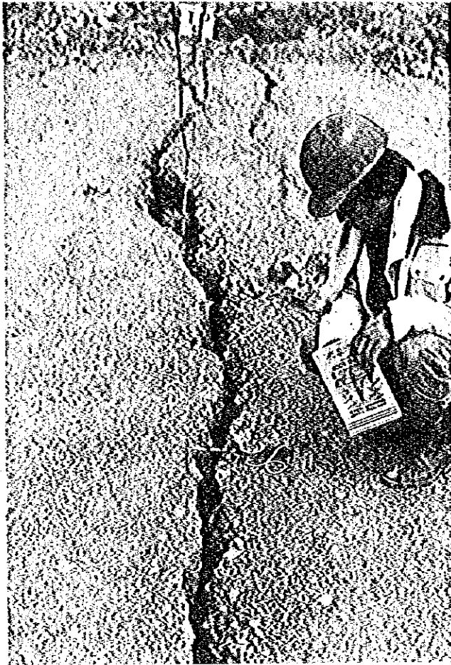
← 堤頂部クラック (T P 5 付近)
