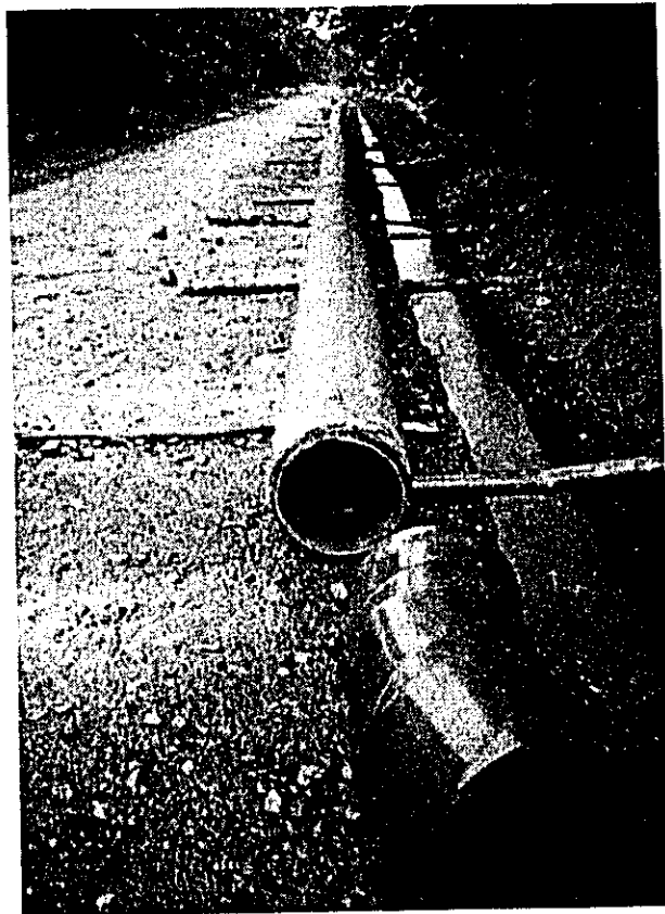
給水管布設工事
