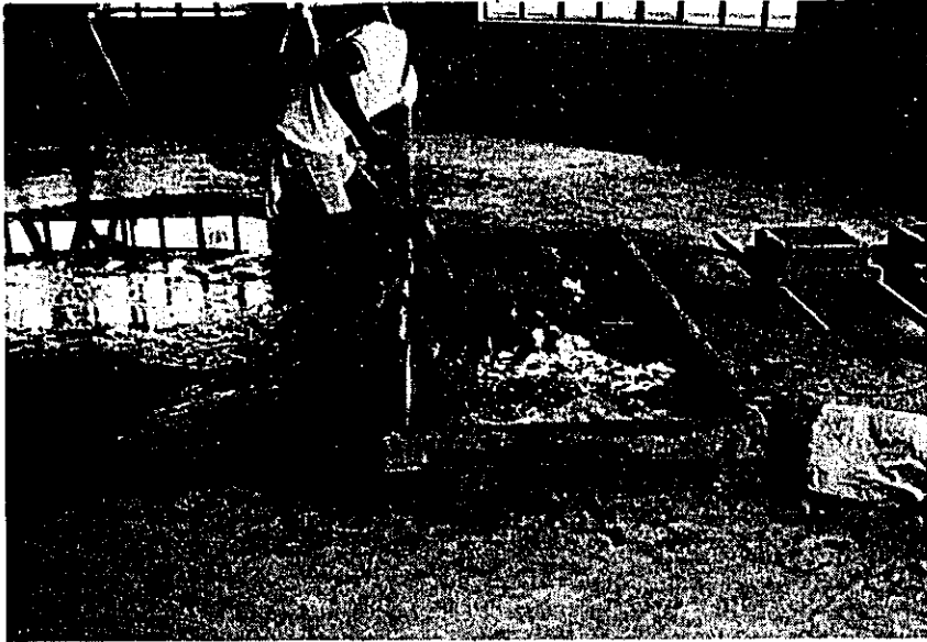
モルタル混練
