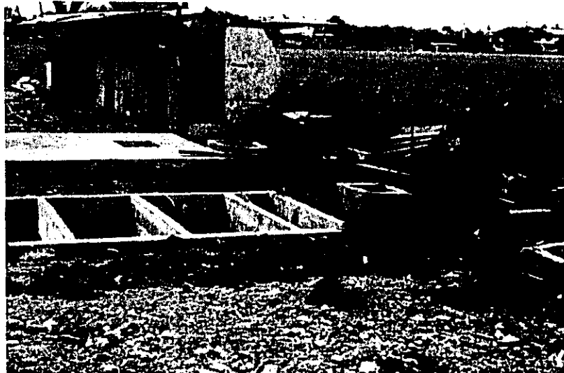
施工中の浄化槽
