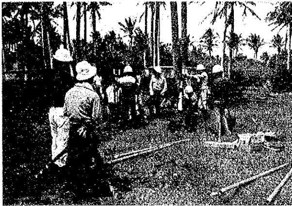
観測用タワーの基礎工事
