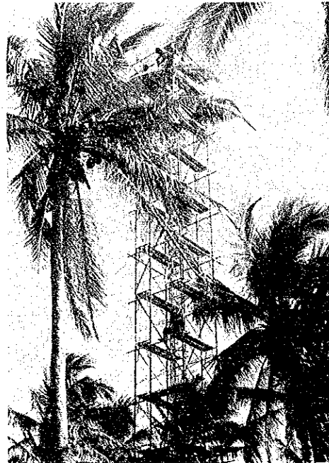
完成した観測用タワー（約24m）
