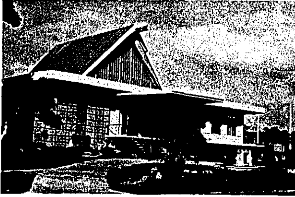
センター本館
