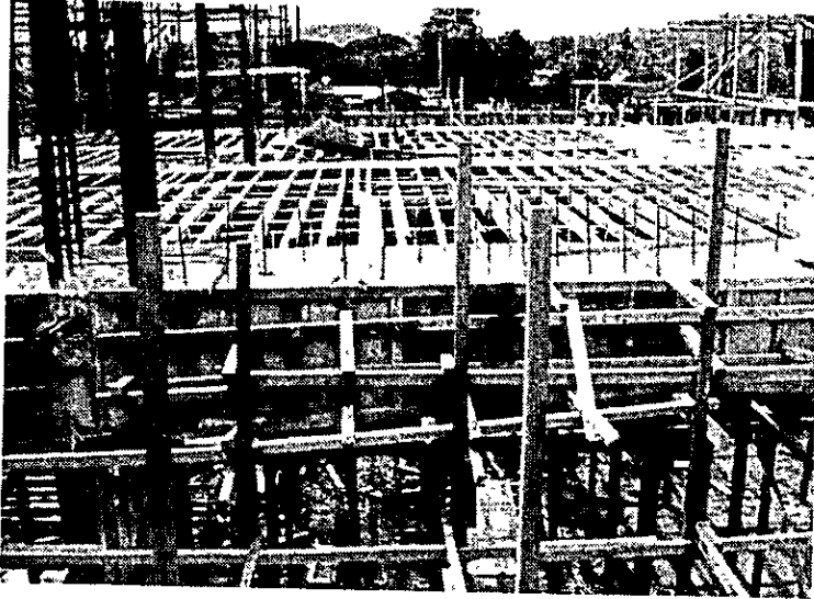
ボホールの建設工事状況
