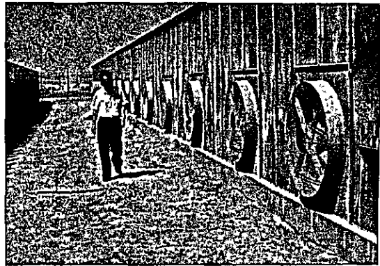
リアド近郊のハウスの 冷房用送風装置のファン
