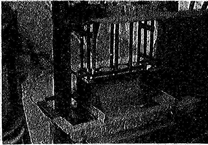
写真-39 小規模の工場で使われているブロック製型機(リヤド)
