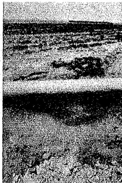
み地下滲透したかんがい水を集水し、サンプ ピットに集め、これをポンプで排水する。これによって地中の塩分はリーチングされる。給水は、簡単にとりはずしのできる特殊な接手を有するアルミニウム管で行う。アルミニウム管は軽く、1人で容易に移動組立、分解ができるので適宜必要個所に移動し、かんがいすることができるようになっている。かんがい水は配管に設けられたスリットからうね間に流出するようになっている。スリットはゲートで適宜開閉できる。こうしたかんがい、排水法をとり入れることによりスワンプ化した土地を農地として再生することに成功したといわれている。なお、このプロジェクトは既に述べた H I D A プロジェクトとは全く無関係に行われているものである。
