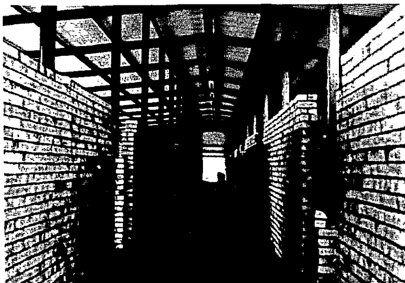
〔訓練棟〕 一般電子の内部
