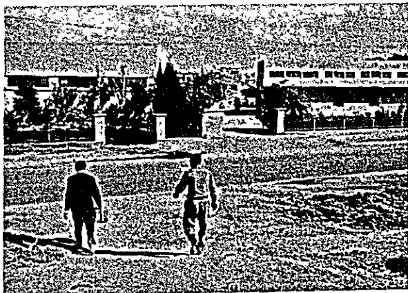
マスバ浄水場
