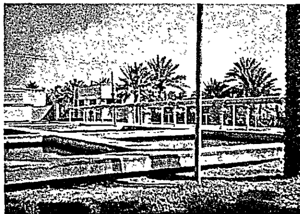
サルジーア浄水場 屋外式急速濾過地
