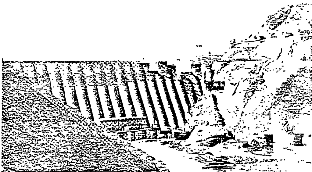
Vue aval du barrage. Evacuateur de demi-fond en cours de construction sur la rive gauche.
