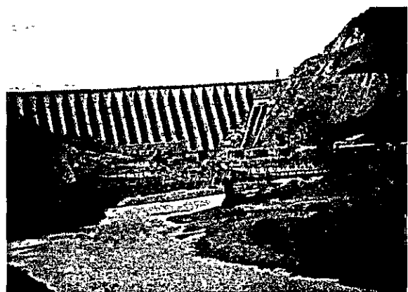
セフィードルード河上流のセフィードルードダム (堤高106m、最大貯水量18億 m^3 )
