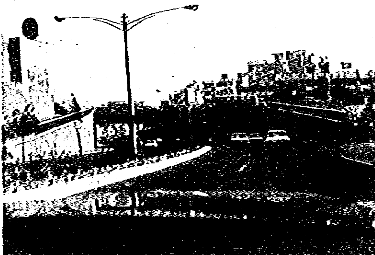
北側からの流入路 SHAHANSHAH I Expressway
