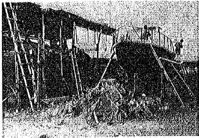
第10図 9トン型コンクリート船の建造所（ラミ水産局）
